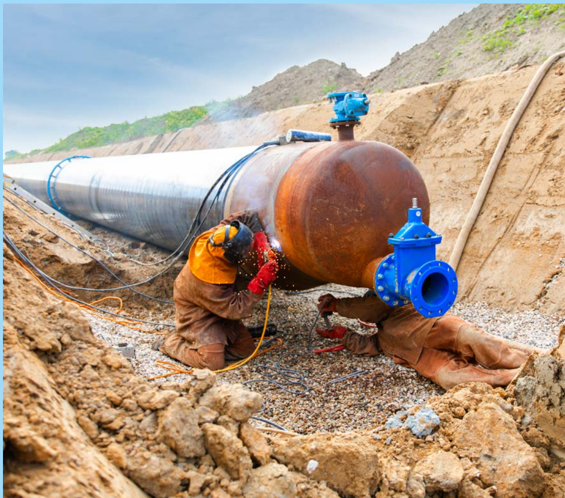
Arbeiten an der Rohrstrecke Pehritzsch
