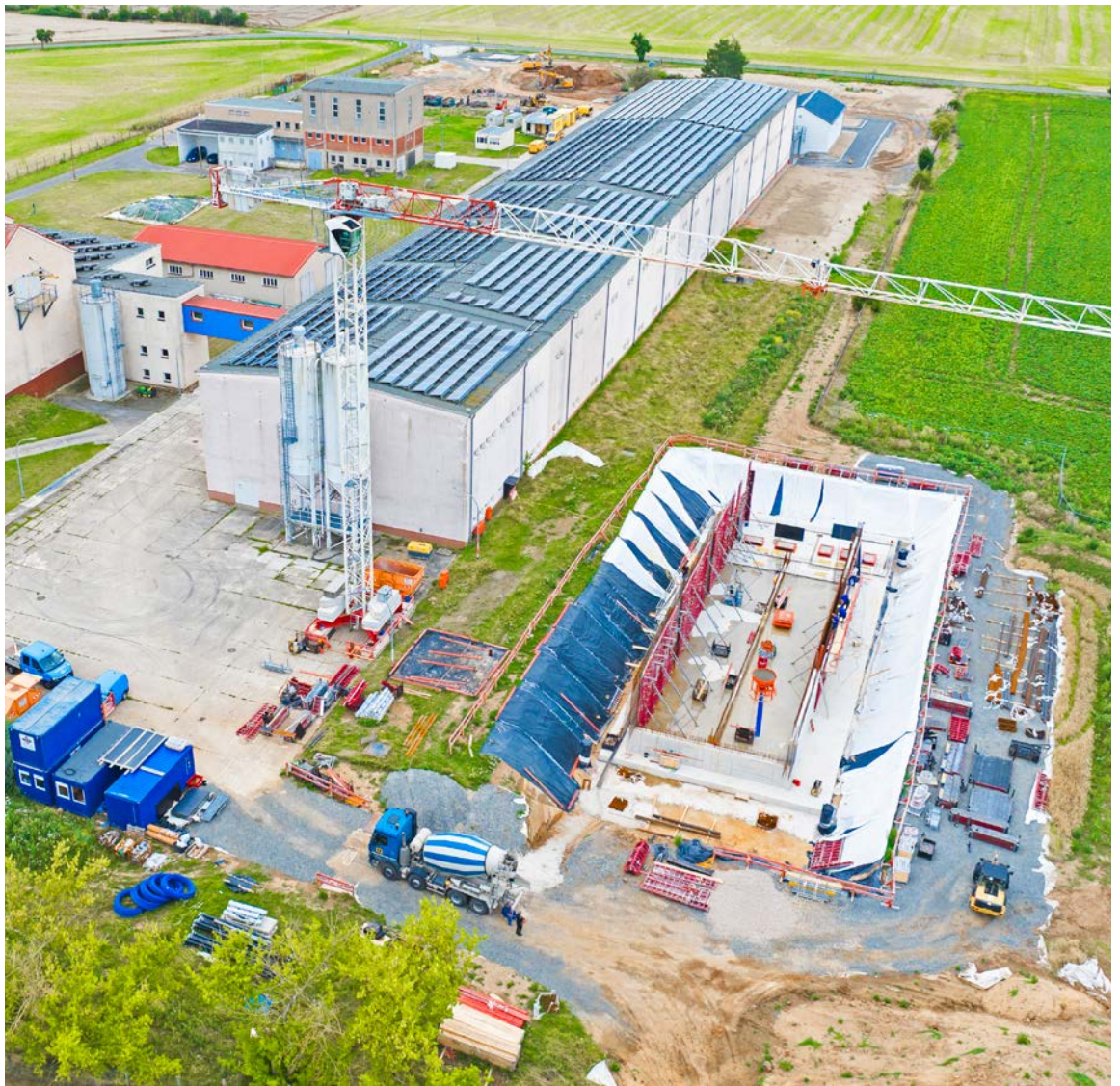
Baufortschritt im Bereich der Mockritzer Schlammbehandlung im Juli 2025
