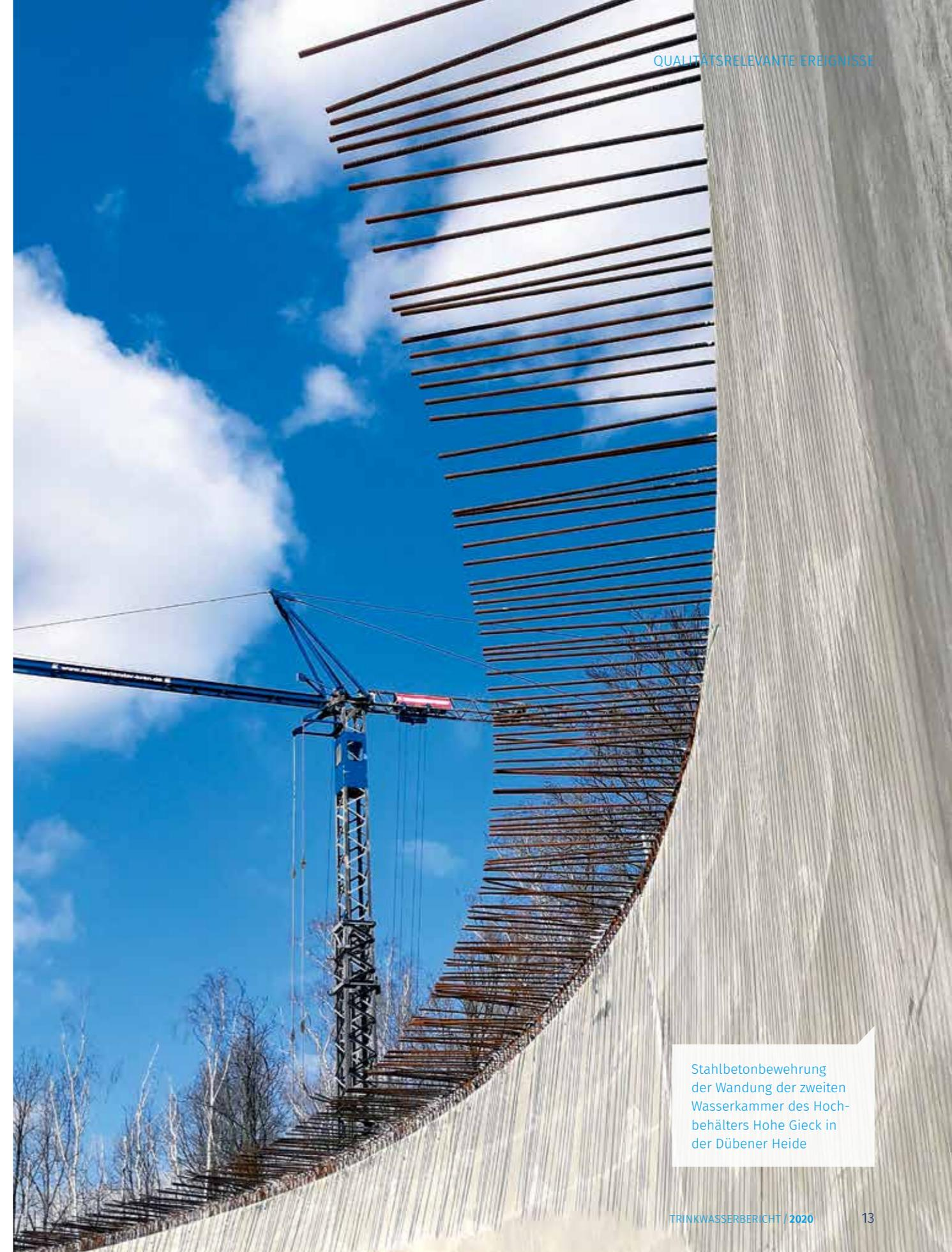
Stahlbetonbewehrung der Wandung der zweiten Wasserkammer des Hochbehälters Hohe Gieck in der Dübener Heide
