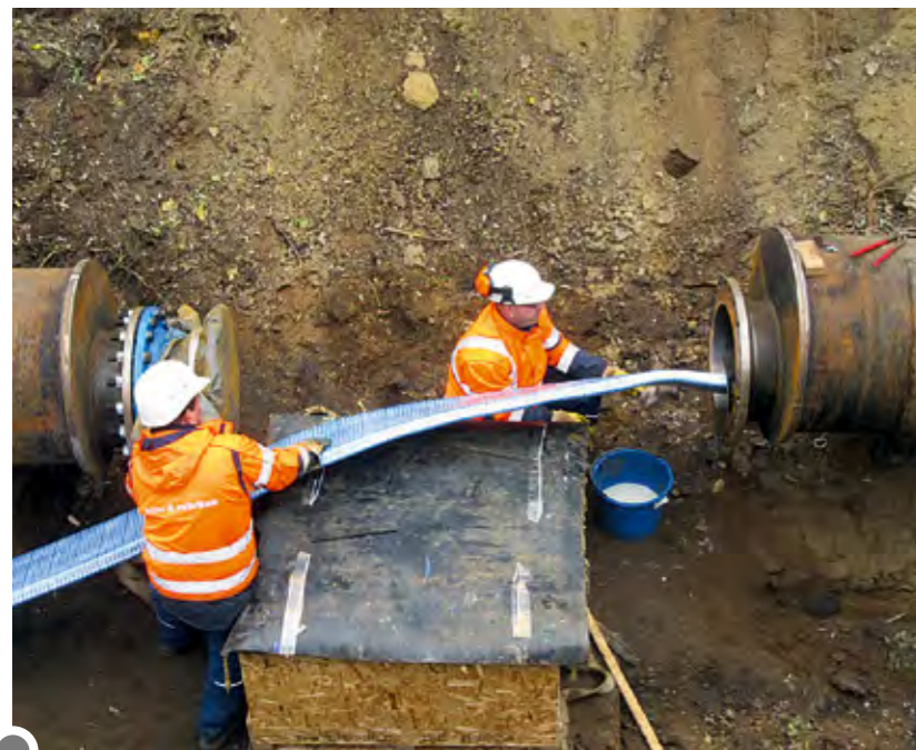
Mit einem flexiblen Kunststoffschlauch wurden rund 1,5 Kilometer Stahlrohr zwischen den Abgabestationen Wachtendorf und Bitterfeld ausgekleidet und so für den weiteren Betrieb ertüchtigt.
