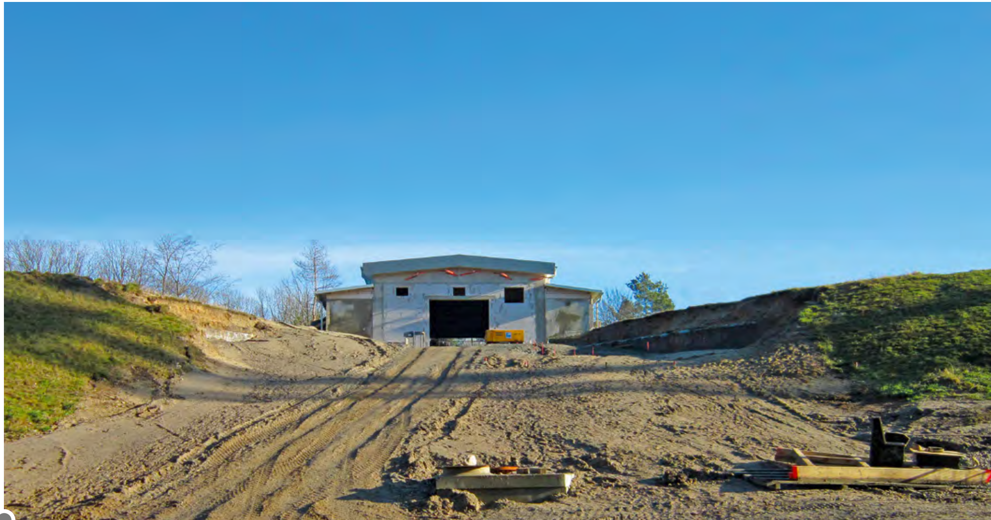
Der Neubau des Schieberhauses des Hochbehälters Hohe Gieck ist nahezu abgeschlossen, demnächst beginnt die Sanierung der Behälterkammern.
