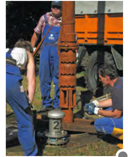
Die Mitarbeiter der Fernwasserver-sorgung Elbaue-Ostharz GmbH bauen eine stark verockerte Unterwassermotor-pumpe aus, um sie zu reinigen und damit die Förderleistung wieder zu erhöhen.
